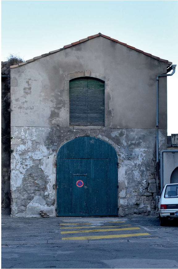
Façade Ouest de l'église de la Madeleine © Sophie Piot
