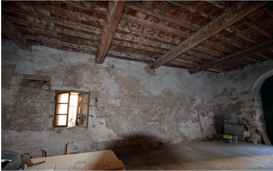
Partie basse du mur intérieur Sud © Sophie Piot
