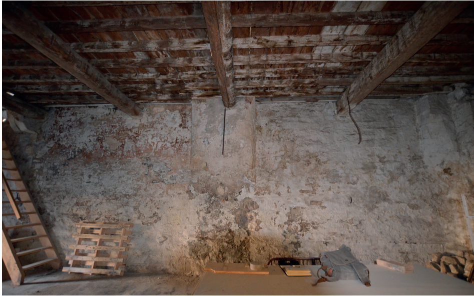
Partie basse du mur intérieur Nord © Sophie Piot
